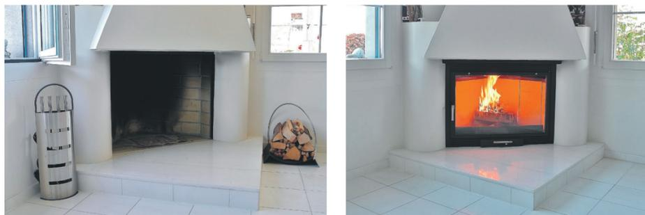
Jetzt das offene oder ältere Cheminée mit einer Hein-Heizkassette sanieren, dadurch jetzt schon die anstehenden EU Emissions Werte erfüllen - und durch den 82 Prozent Wirkungsgrad erhebliche Heizkosten einsparen.
